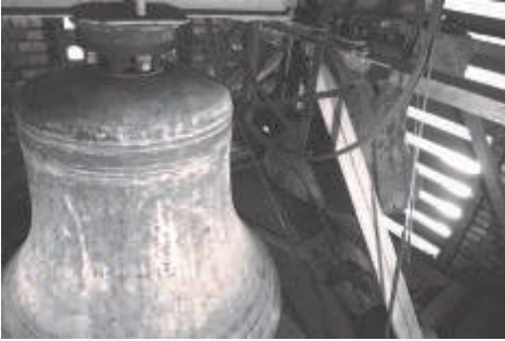
Der neue, stählerne Glockenstuhl.
