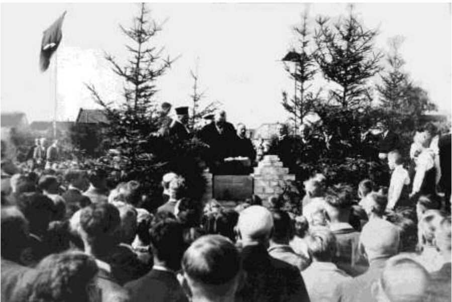
Grundsteinlegung am 1. August 1937
